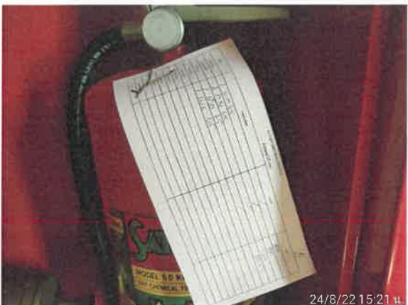
รูปที่ 2-38 แสดงการตรวจสอบอุปกรณ์ดับเพลิงภายในโครงการ
